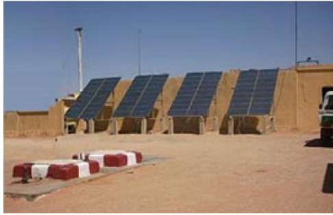
(ب) المحطة الشمسية المستعملة لتشغيل محطة التحلية
