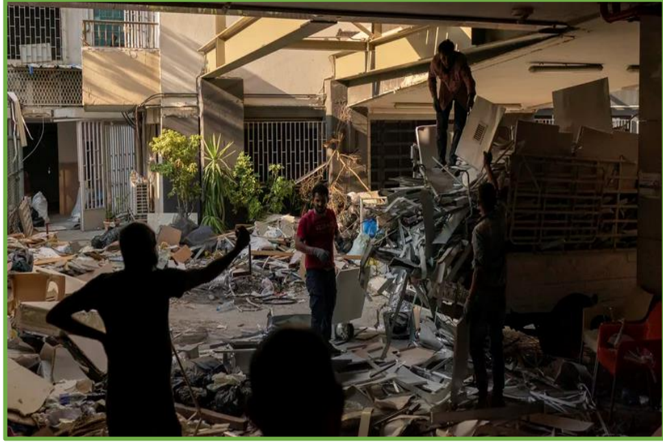
عمال يزيلون حطام مستشفى تضرر بشدة في انفجار ميناء بيروت، (أغسطس 2020)
